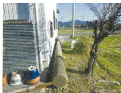
④ 建物南側
