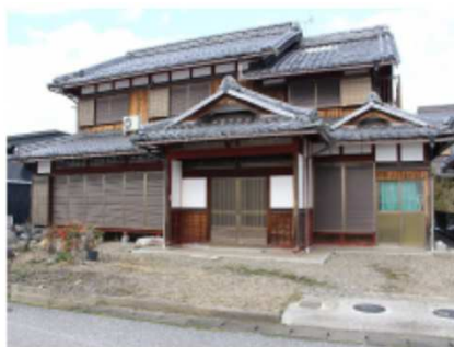
No. ① 建物正面
